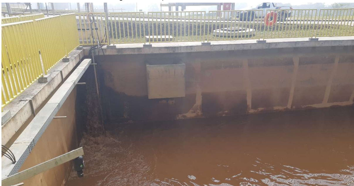
Figura 4- Tanque de lodo concentrado
