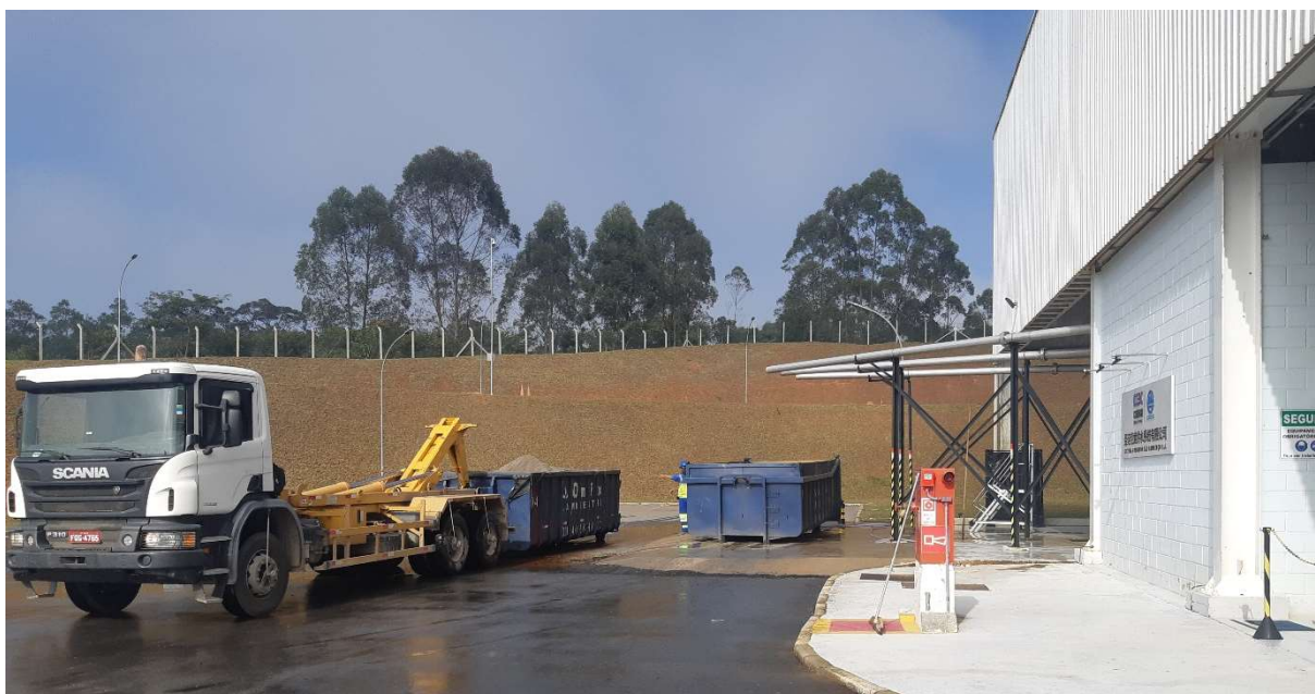
Figura 5 - Sistema de coleta e transporte do lodo desidratado
