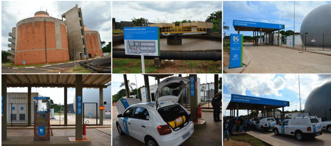
Figura 01 – Fotos da ETE de Franca e do abastecimento de frota de veículos da Sabesp.
