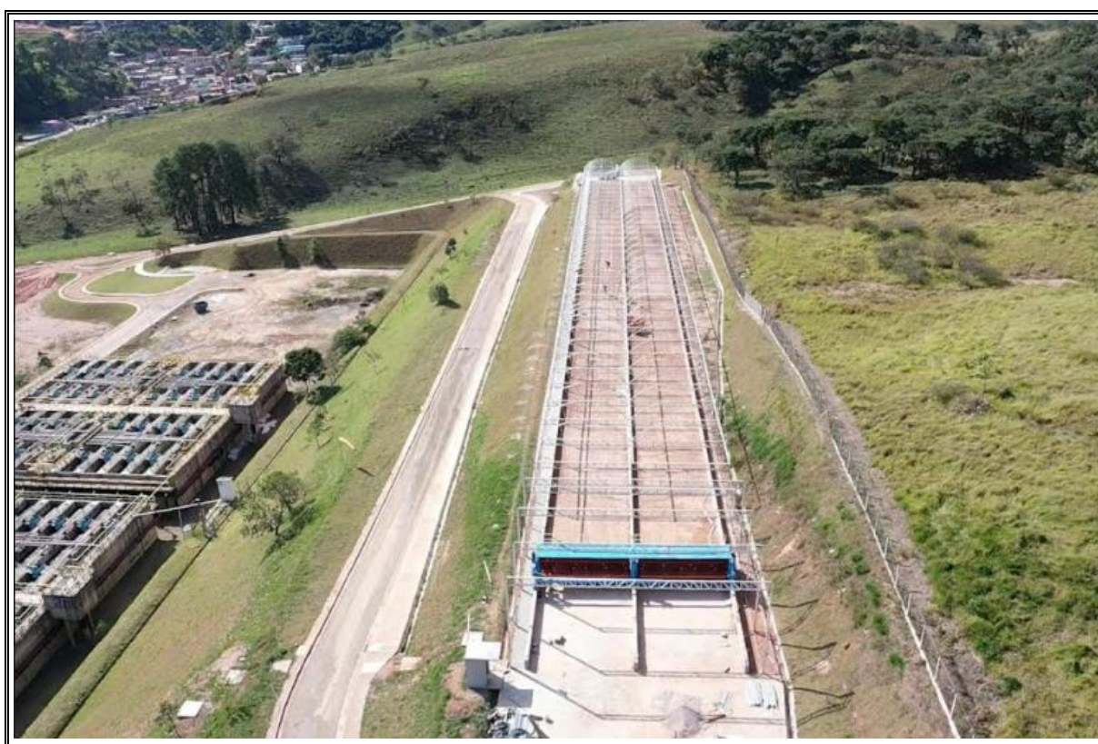
Figura 3 - Vista aérea das obras de implantação do secador solar de lodo. Fonte: SABESP (junho/2020).
