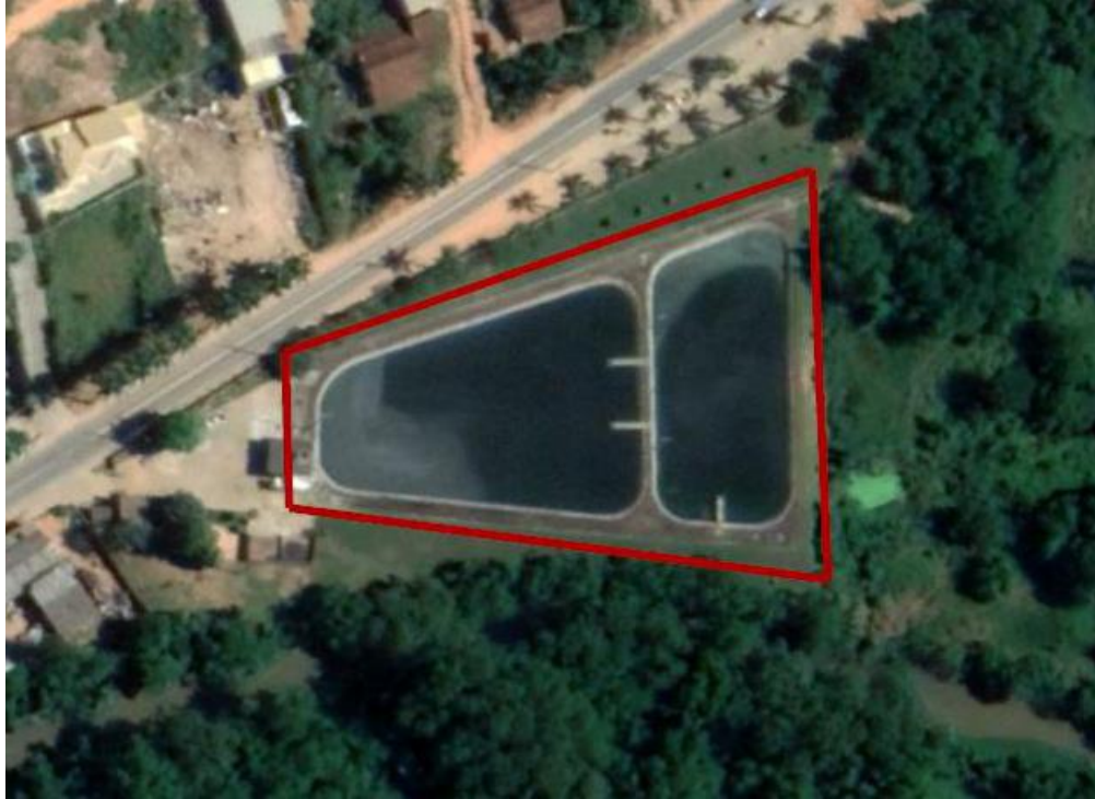
Figura 4 – ETE Barra de São Francisco, formada por duas lagoas anaeróbias
