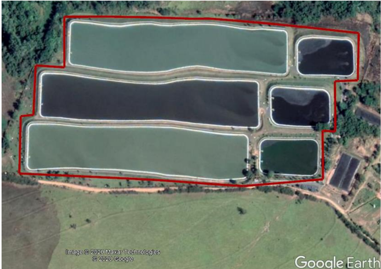
Figura 5 – ETE Lins, formada por três conjuntos do sistema australiano
