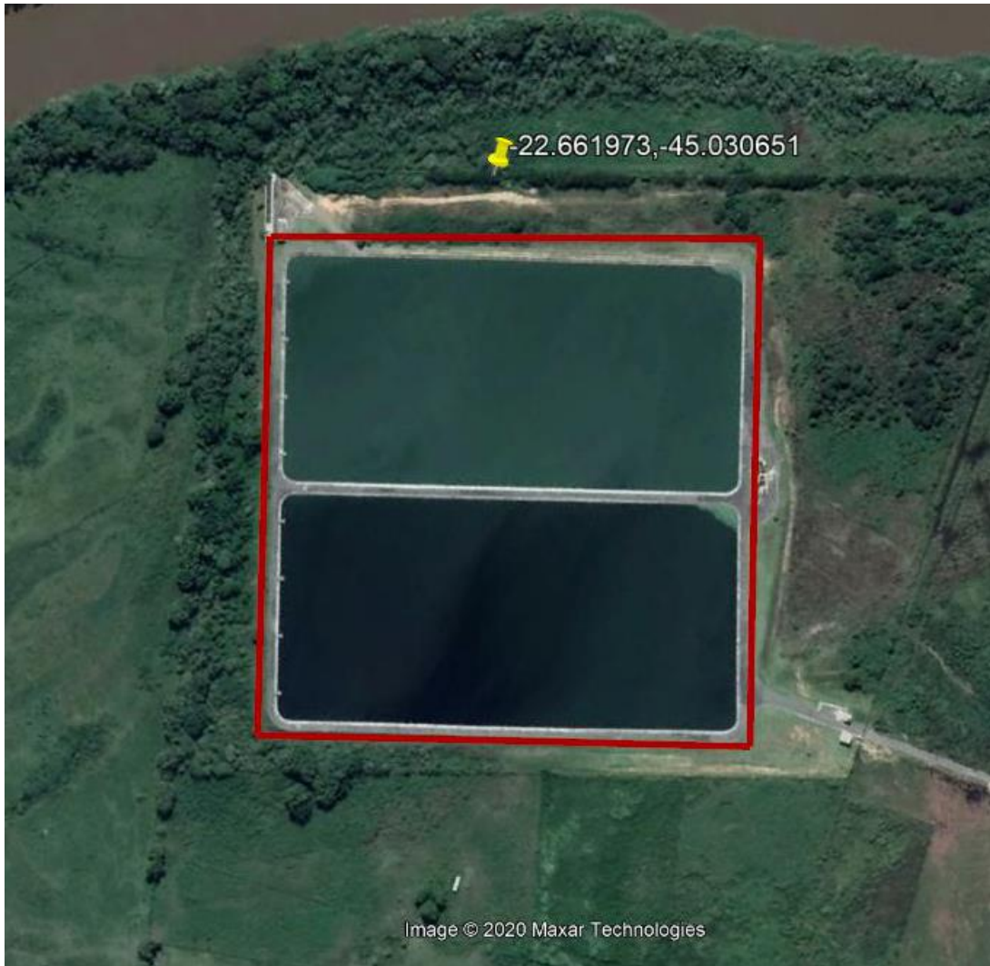
Figura 1 – ETE Sede, formada por duas lagoas facultativas
