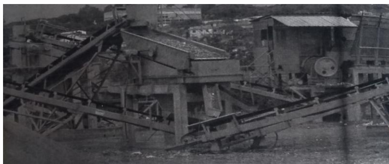
Figura 8: Equipamentos da Usina de reciclagem de Piracicaba
