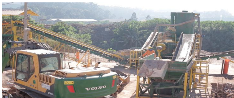
Figura 9: Implantação de usina de reciclagem no Jorge Lanner criará quase 100 empregos
