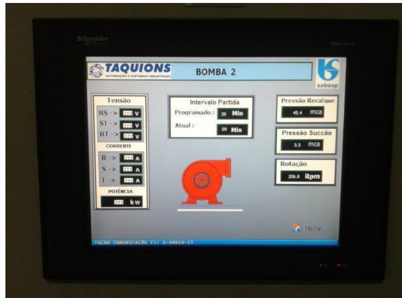
Figura 4 – Instalação do sistema de bombeamento
